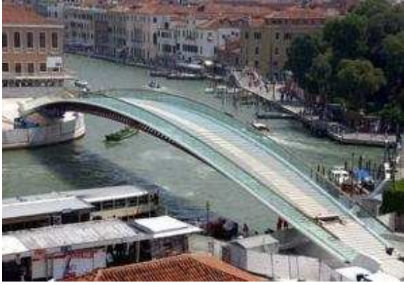
Ponte della Costituzione Venezia
